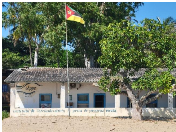
Photo 12 : Bâtiment de l'IDPPE. Prise par Inès Duquesnoy, en 2026 à KaNyaka
